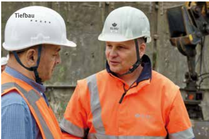
Aufsichtsperson Markus Mohr im Gespräch bei der Baustellenbegehung
