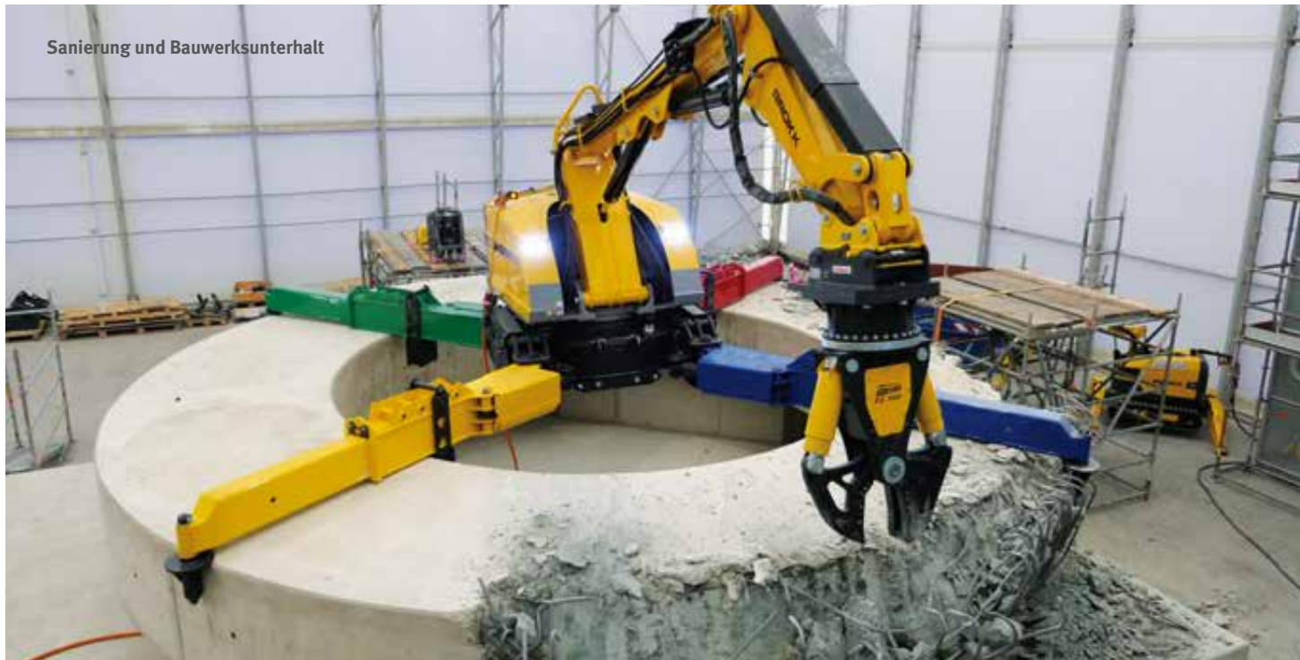
Abbruchroboter mit Spinnenunterbau auf einem eigens hierfür errichteten Teststand
