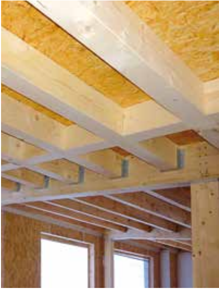
Die Decken wurden als Holzbalkendecken ausgeführt.
