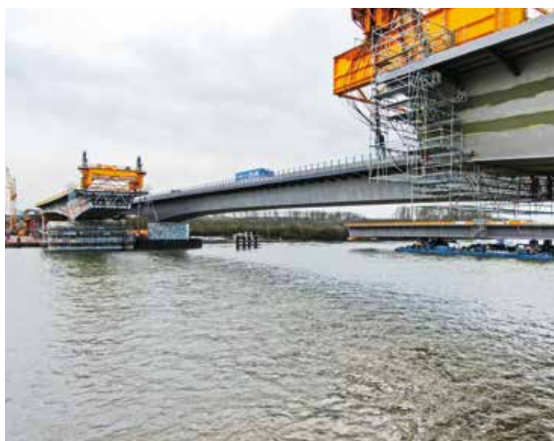
Abb. 5: Baulücke für das eingeschwommene Teilstück
