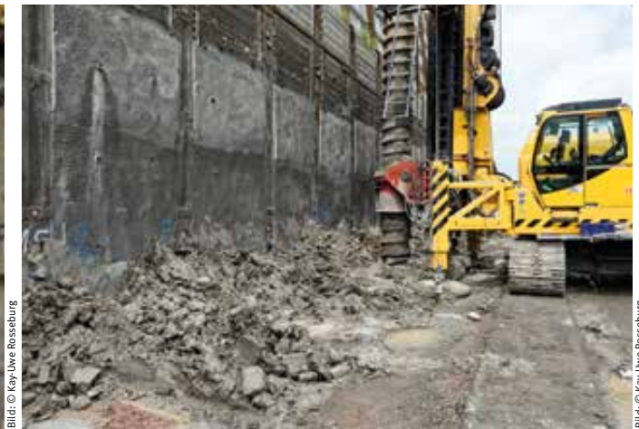
Schweres Bohrgerät für die Pfahlgründung
