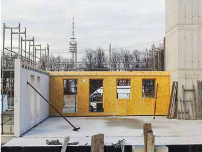
Beginn der Holzbau-Montagearbeiten auf der Decke der Tiefgarage
