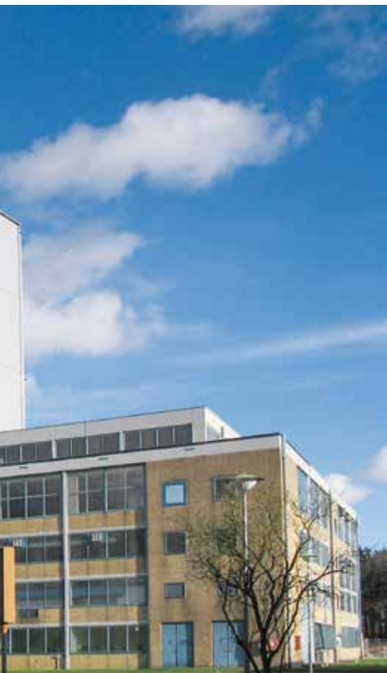
Außenansicht der AVR-Anlage
