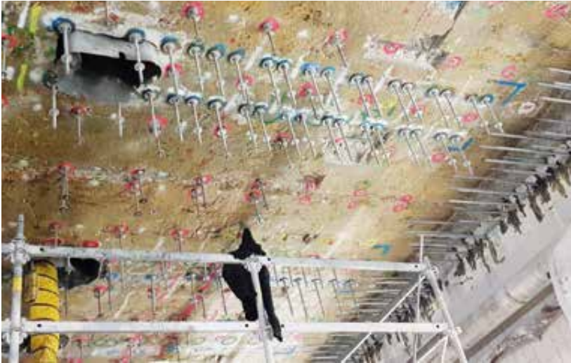
Abb. 6: Einbau der Verstärkung an der Nordseite des Tunnels
