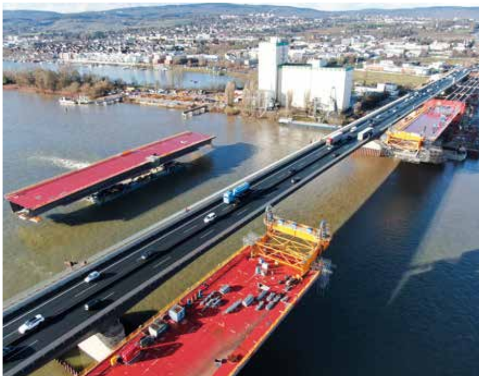
Abb. 4: Einschwimmen eines Teilstücks
