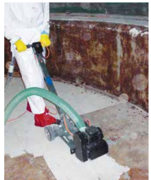
Emissionsarmer Abtrag asbesthaltigen Klebers mit Bodenfräse
