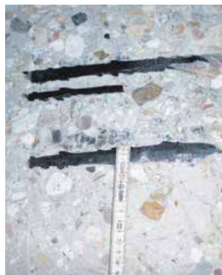
Betonoberfläche nach Abtrag von 10 mm Betondeckung
