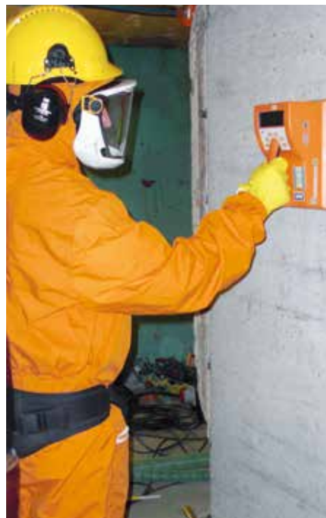
Messung der Kontamination der Betonoberfläche nach erfolgtem Abtrag
