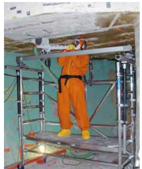
Abtrag der Betonoberfläche mittels Deckenfräse
